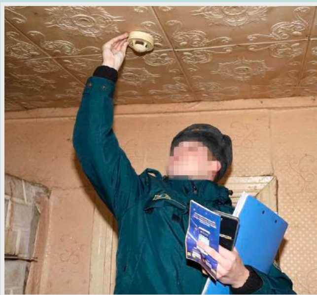
Предложите домовладельцу продемонстрировать (при наличии возможностей) исправность автономного пожарного извещателя
